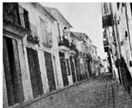
Carrer Major nº 3.
